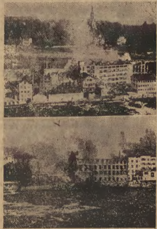
U góry: Nowa fabryka jedwabiu w Szafuzie, która zupełnie się spaliła. U dołu: Szkody w dzielnicy mieszkaniowej miasta.
