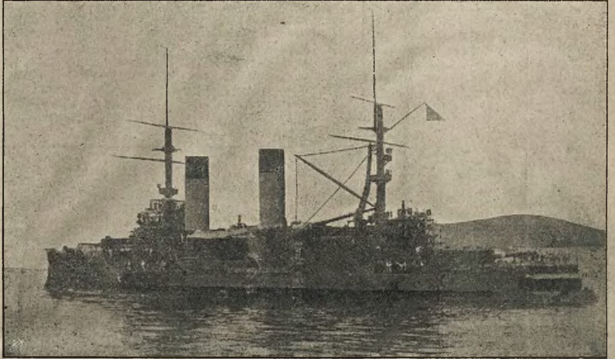
•BORODINO•, pancernik rosyjski, zbudowany w r. 1901, pojemności 13'00 tonn, o szybkości 17.18 mil morskich. — Jego uzbrojenie składa się z 4 dział 30'5 ctm., 12 dział 15 ctm., 20 dział 7'5 ctm., 22 dział 4'7 ctm. i 8 kartaczownic, nadtó 4 rur torpedowych. Zapas węgla wynosi 2000 tonn. Załoga liczy 782 ludzi.
