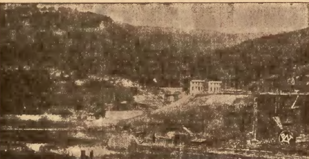
Lzęść tamy, która znajduje się obecnie w budowie.
