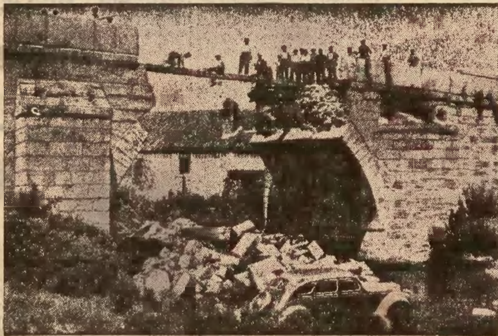
Aby utrudnić powstańcom zdobycie Madrytu, wojska rządowe wysadziły w powietrze strategiczny most nad rzeką Guadarrama.
