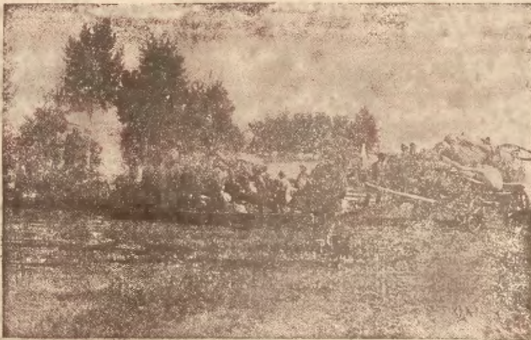
KŁĘSKA POWODZI Ratowanie dobytku powodzien w Sandomierskiem.
