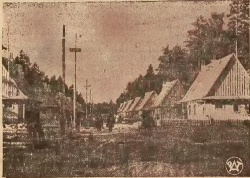
Staraniem Kierownictwa Państwowych Kamieniołomów w „Janowej Dolinie” buduje się i jest na ukończeniu piękne osiedle dla robotników tego kamieniołomu. Jak widzimy na zdjęciu, domki tego osiedla są bardzo estetyczne i malowniczo położone w pięknym lesie.
