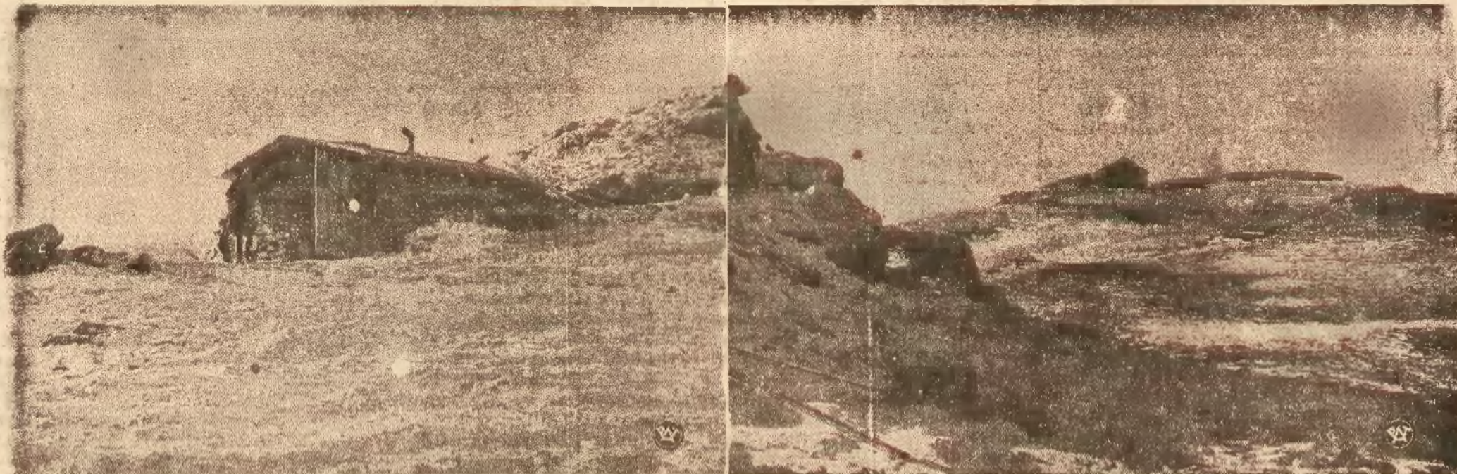
Podajemy dwa zdjęcia z budowy obserwatorium meteorologiczno - astronomicznego, budowanego jak wiadomo, przez L. O. P. P. dla celów naukowych ze szczególnym uwzględnieniem potrzeb lotnictwa, na Popovanej w Czarnohorze.
