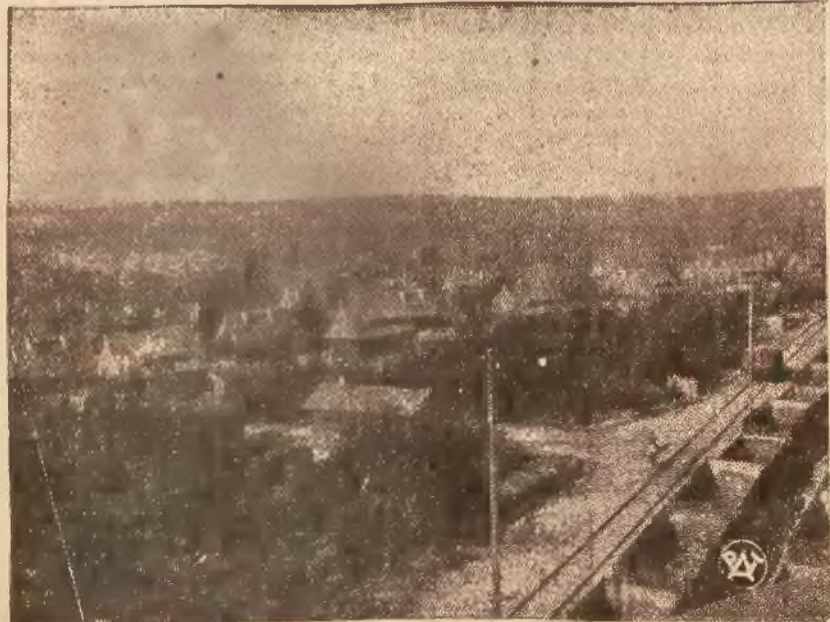
Ogólny widok nowopowstałej kolonii robotniczej w Państwowych Kamieniołomach w Zagnańsku. Kamieniołomy te zatrudniają w obecnej chwili 1500 osób.
