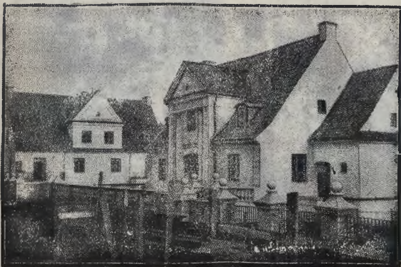
NOWA WARSZAWA, nowoczesne domy robotnicze.
