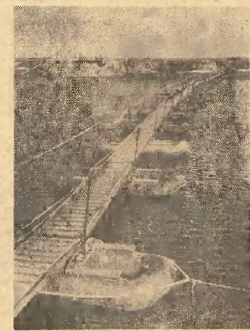
Na północnym odcinku frontu wschodniego: Poniższy z łodzi powstały w przeciągu 2 godzin.
