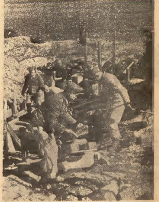
Na jednym z wybrzeży europejskich odbywa się budowa pozycji bojowych.
