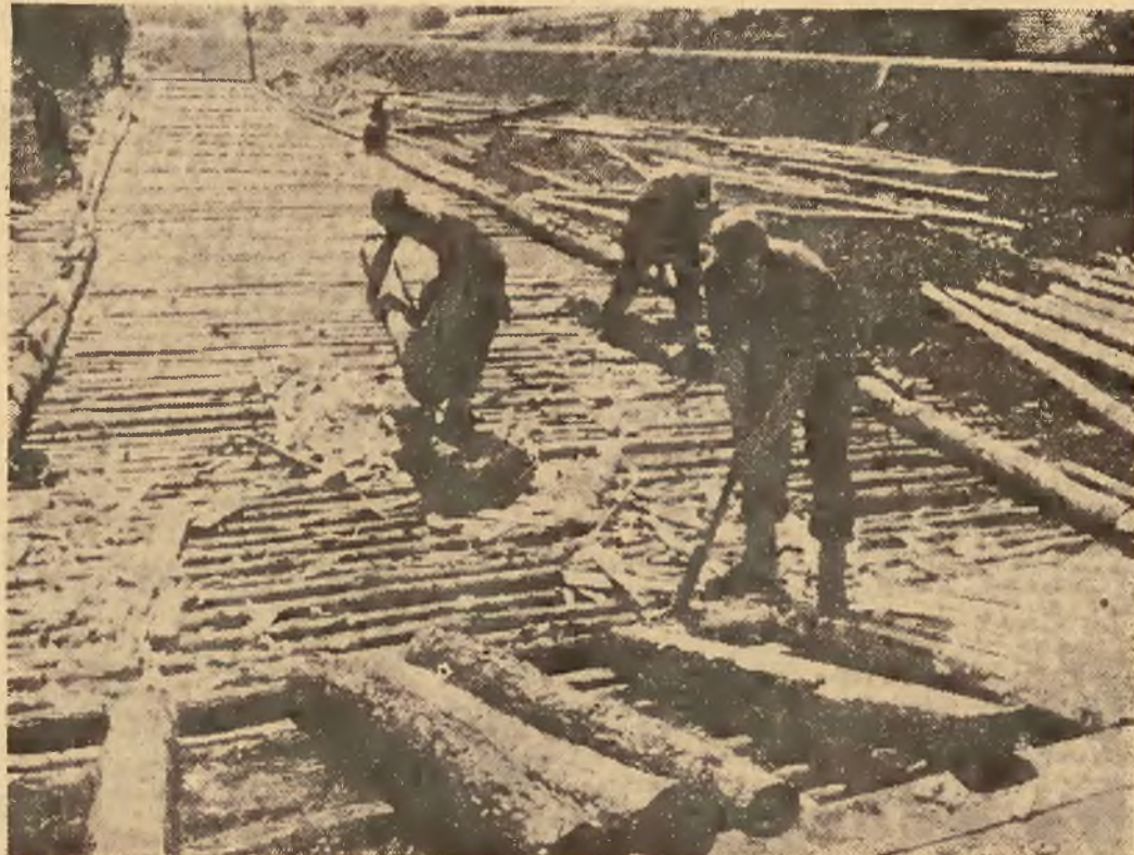
Pionierzy są mistrzami budowy gościńców. Rycina nasza przedstawia budowę drogi, do której użyto materiału drzewnego.
