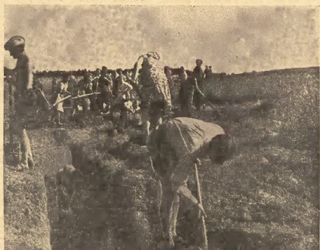
Kobiety formują wyrzucaną z rowów ziemię w przepisowy kształt „przedpiersia” okopów.
