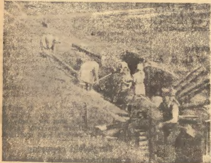
Fragment budowy umocnienia.
