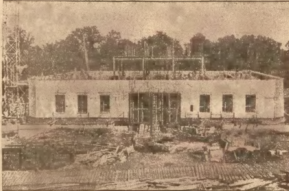
buduje się obecnie w Forcie Knox. Główne wejście do skarbcia zaopatrzone jest w drzwi, ważące 35 ton.
