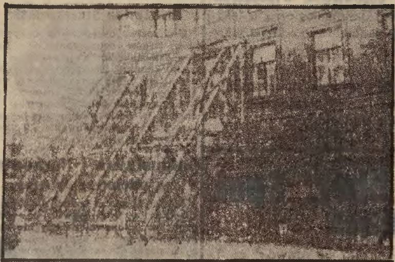
Kompleks podstemplowań, chroniących ścianę kamienicy przy ul. Podwałe Nr. 18 przed zawaleniem się.
