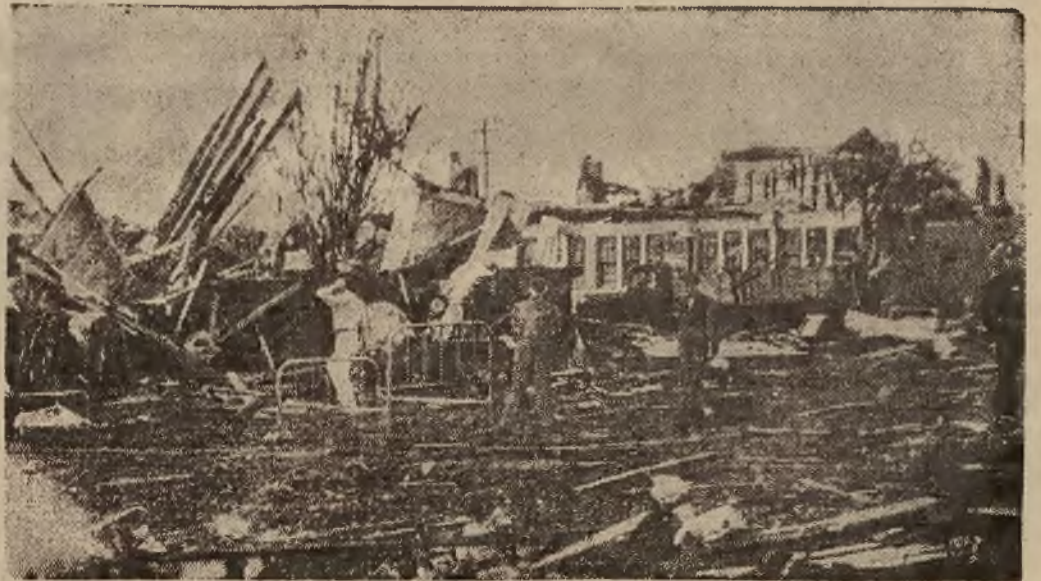
Na zdjęciu — fragment zniszczenia miasta Clyde w stanie Texas, spowodowanego niszczycielskim, rozszalałym tornado, podczas którego szereg osób poniosło śmierć, w zasypanych z kami zburzonych domach.
