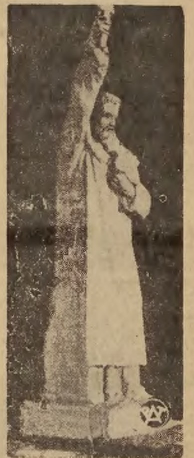
W Szczytnikach koło Iwanowic, obok Kalisza, rozpoczęto budowę pomnika bohatera Jasnej Góry, ks. Kordeckiego. Podczas swej inspekcji na terenie powiatu kaliskiego, p. premier gen. Składkowski zbadał dokonane roboty przy budowie pomnika i wydał doraźne dyspozycje. Na zdjęciu — makieta pomnika ks. Kordeckiego.
