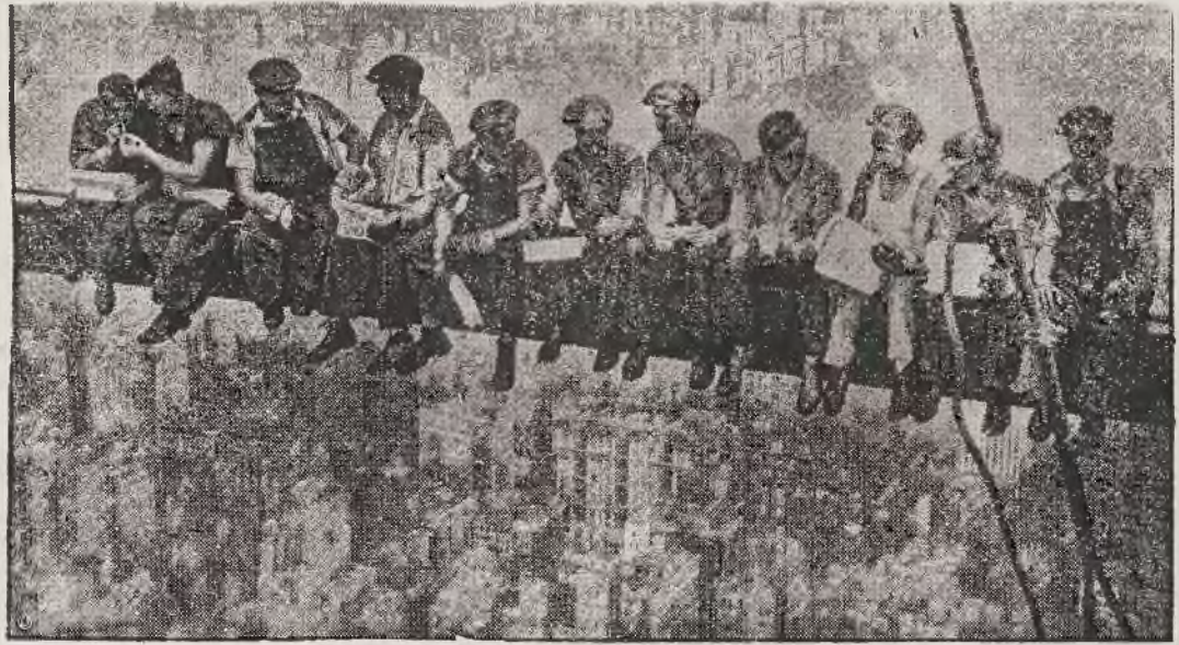
Pracownicy przy obiedzie na wysokości 20 pięter przy budowie drapacza chmur w Chicago.
