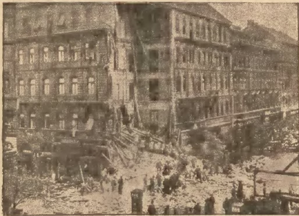
W Budapeszcie zvaliła się ściana kilkupiętrowego domu, grzebiąc 40 mieszkańców i przechodniów. Dotychczas zdołano wydobyć tylko nieliczne zwłoki ofiar.
