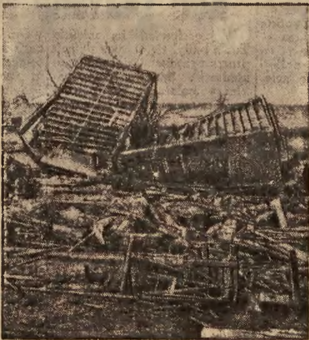
Zrujnowany dom w Heyworth (stan Illinois) przez szalejący orkan.
