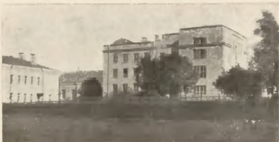
Sąd Okręgowy w Nowogródce, zbudowany i częściowo przebudowany w 1930 — 31 r.
