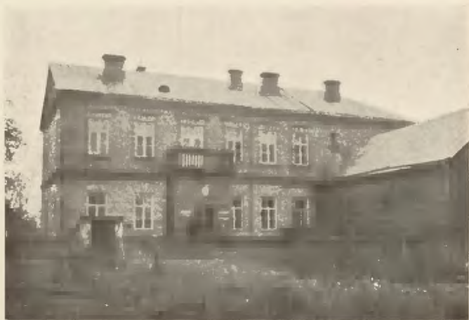
Wydział Zamiejscowy w Lidzie Sądu Okręgowego Wileńskiego. Budynek prywatny wydzierżawiony.
