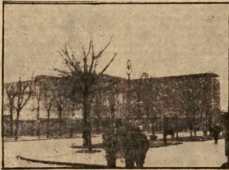
Nowy Dworzec Centralny Warszawy jest już prawie na ukończeniu
