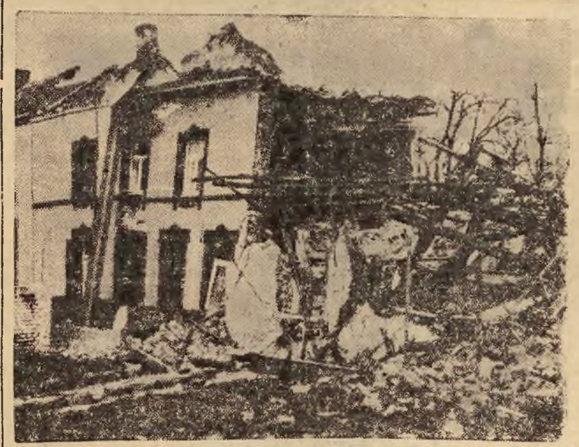
W belgijskiej miejscowości Souvret, obok Courcelles miało miejsce prawdziwe trzęsienie ziemi, spowodowane ruchami tektonicznymi w podziemnych pokładach okolicznych kopalni węgla. Skutki podziemnych wstrząsów były straszliwe gdyż obróciły w gruzy 26 domów mieszkalnych, grzebiąc wiele ofiar
