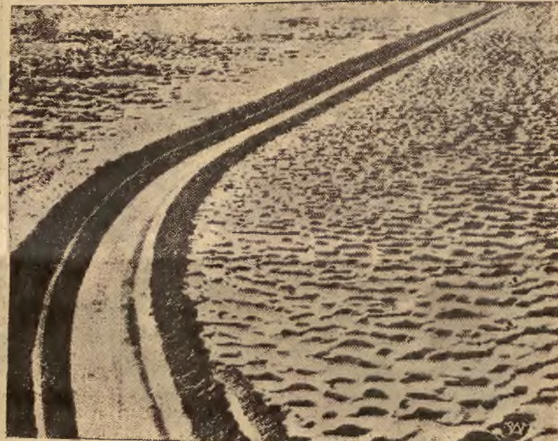
W Ameryce podjęte zostały roboty nad budową kanału, który zaczynać się będzie przy rzece Kolorado w pobliżu miejscowości Yuma w stanie Arizona i bieć będzie przez obszary pustynne w okolicach Kolorado do doliny Imperial, w Południowej Kalifornii. Długość kanału wynosić będzie około 130 klm., a szerokość 86,5 mtr. Koszta budowy obliczone są na 35 milionów dolarów. Po zakończeniu budowy kanału około 4,5 tys. klm. kw. w pustyni będzie mogło być nawodnione. Na zdjęciu — budujący się kanał.
