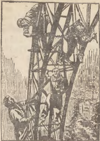
Robotnicy przy lakierowaniu konstrukcji wieży Eifla w Paryżu.
