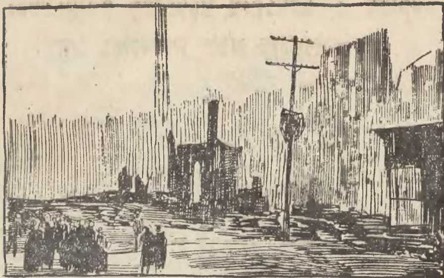
Olbrymi pożar w Jersey City (Stany Zj.) obrócił w perzynę cały kompleks wielkich budynków. Rycina przedstawia pogorzeliśko w tej części, gdzie powstał pożar.
