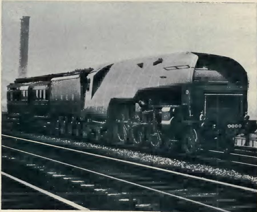
Nowa olbrzymia lokomotywa zastąpiła dotychczasowe. Oddana do użytku kolei angielskich. Jej charakterystyczną cechą jest brak kominów, które ukryte są między płytami stalowymi konstrukcji.
