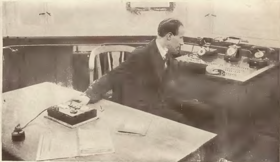
Centrala elektrowni berlińskiej. Tastry widoczne na stole służą do zapalania światła na wszystkich ulicach miasta.
