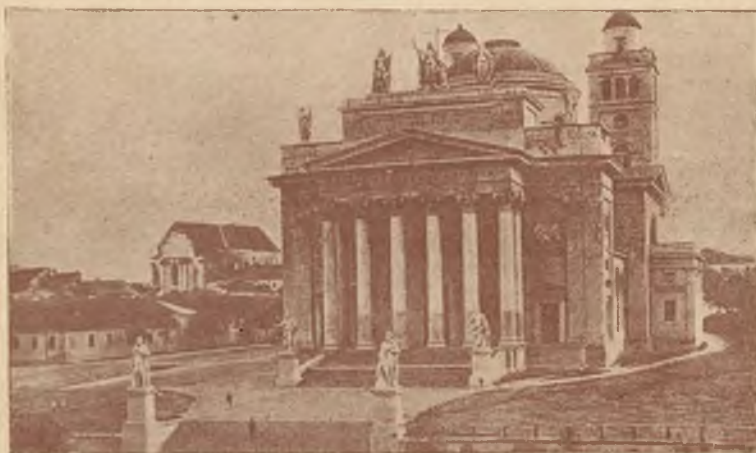
Kościół w Erlau, który z powodu trzęsienia ziemi uległ zupełnemu zniszczeniu.
