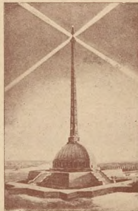
Latarnia morska ku czci Krzysztofa Kolumba, wysokości 30 metrów, wzniesiona niedawno w San Domingo podług projektu inżyniera Ben M. Levithane.
