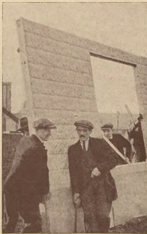
W Ameryce, krainie wszelkich możliwości, technika nowoczesnego budownictwa przystąpiła do budowania domów ze stali; jak widzimy, fabryki dostarczają prawie gotowych już ścian.
