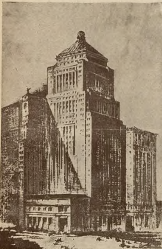
Bank Morgana rozpoczął obok giełdy nowojorskiej budowę nowego 34-piętrowego drapacza.
