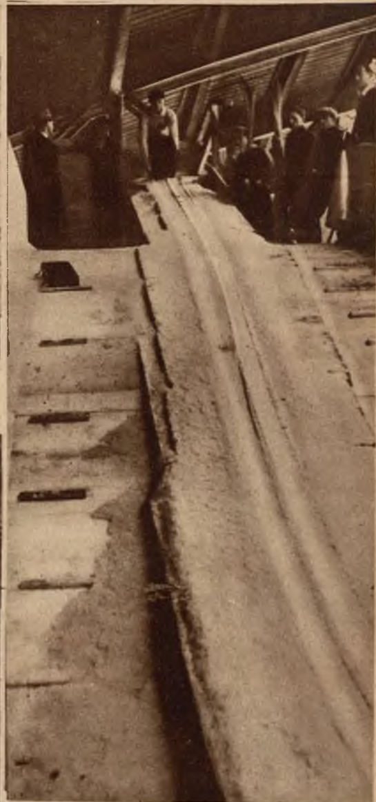
Wiedeński dworzec północno zachodni przebudowano na „Śnieżny Pałac”, gdzie zamieszani sportowcy przez cały rok będą się mogli poświęcać narciarstwu na sztucznym śniegu.
