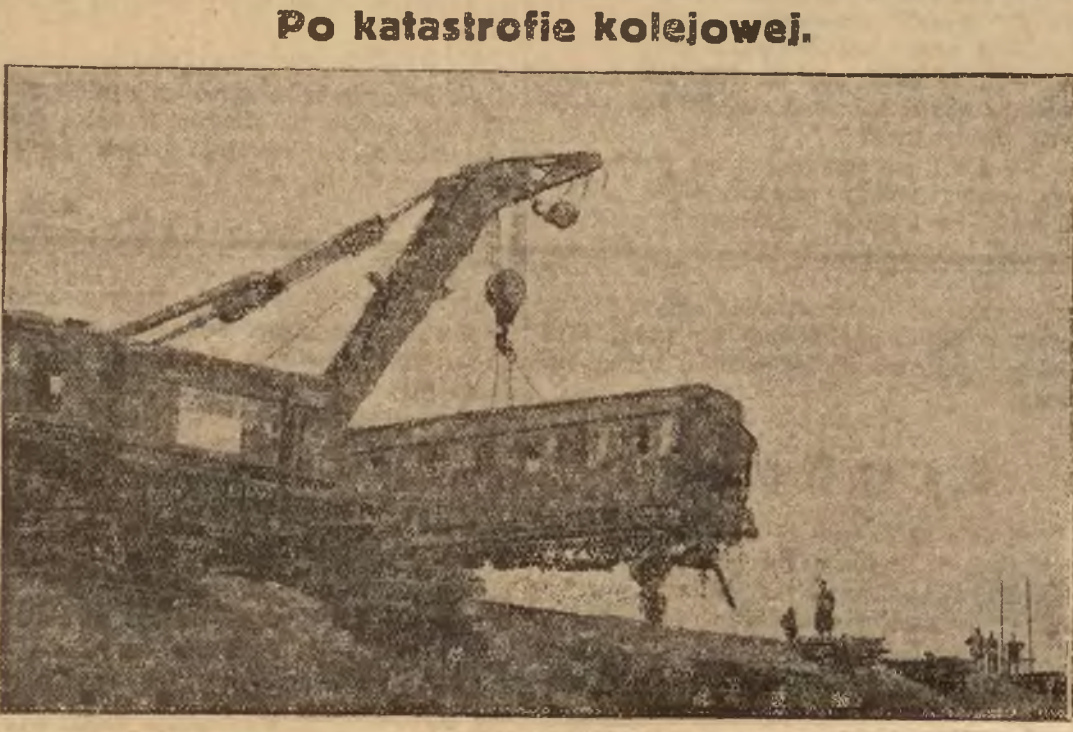
Pod Unią w Westfalji wydarzyła się niedawno groźna katastrofa kolejowa. Skutkiem obciążenia się nasypu, wagony kolejowe stoczyły się w sąsiadujący z torem kolejowym moczarski i dopiero przy pomocy specjalnych kranów zdołano je stopniowo wyciągnąć z bagniska.
