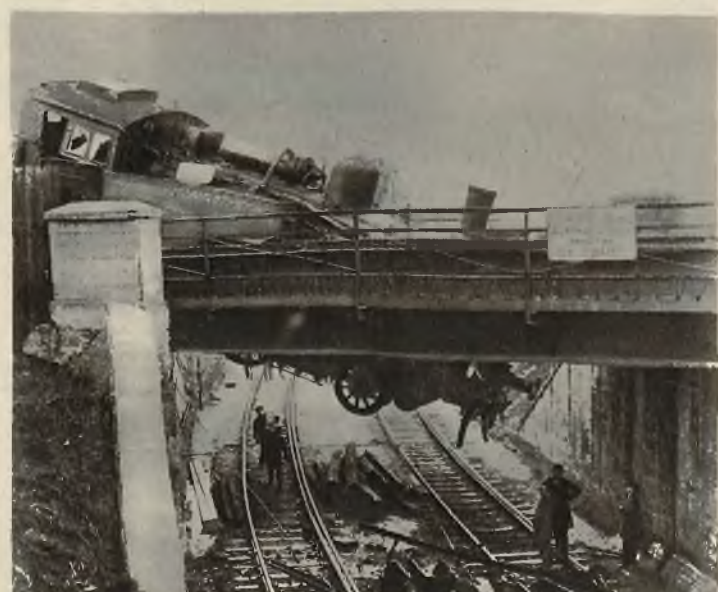
Zdjęcie z katastrofy kolejowej pod Berlinem. Most załamany pod ciężarem lokomotywy.
