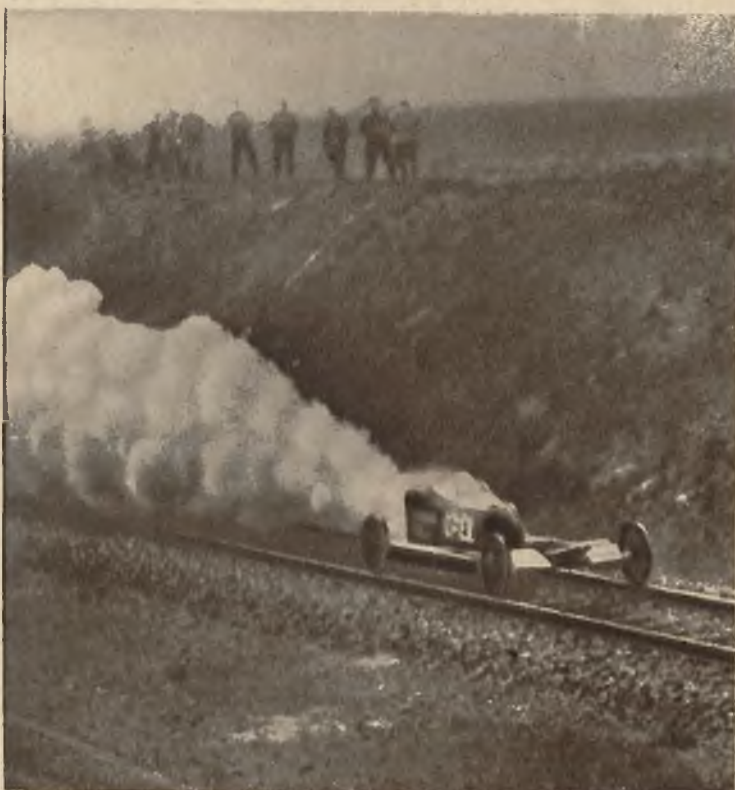
Na linii kolejowej Burgwedel-Celle odbyły się nowe próby wozu raketowego Opla, na szynach. Przy pierwszej udanej próbie osiągnięto 254 km. na godzinę przy drugiej próbie która miała być 4 razy silniejsza, wóz się spalił. Na lewo wóz „Opel Rak III“ (w białym płaszczu inż. Opel). Na prawo wóz w pełnej jeździe.
