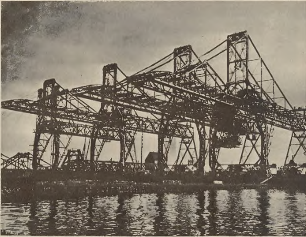
Potężne konstrukcje żelazne zakładów Kruppa w Essen.
