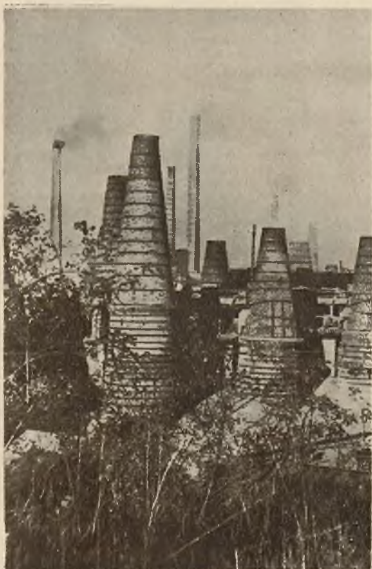
Nowoczesne zakłady wydobywania i wypalania wapna, w których skład wchodzi kilkanaście pieców.
