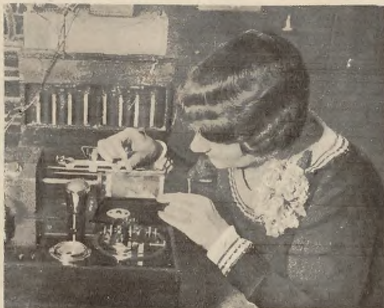
Od 20 listopada wprowadzono w Niemczech na większą skalę aparaty do przesyłania obrazów drogą radjotelegraficzną. Oto aparat nadawczy i odbiorczy przy pracy. Nadanie jednego obrazka trwa do 3 minut.
