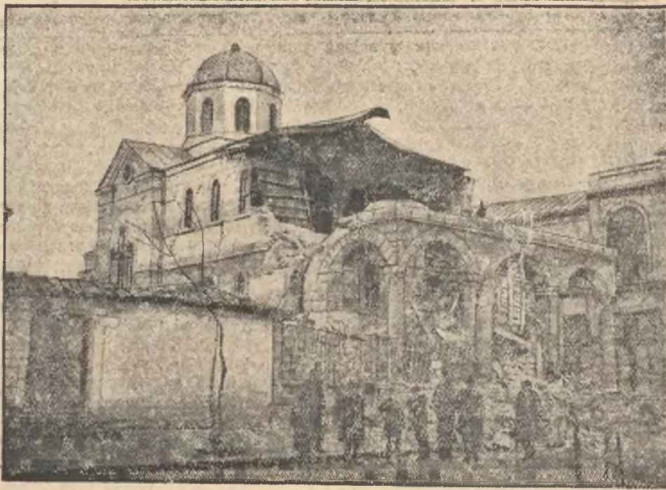
Podczas niedawnego trzęsienia ziemi w Albanii, w miejscowości Korcza zawałił się kościół, grzebiąc w gruzach kilkadziesiąt osób. Oto widok zdemolowanego całkiem we wnętrzu kościoła, na którym cudem utrzymała się wieża.
