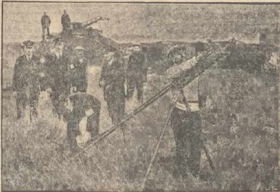
urządzone ostatnio na wybrzeżu angielskim na wypadek rozbicia się okrętów podczas burz morskich. Zapomocą takiej rakiety wyrzeliwuje się na zagrożony statek liny, po których może się przedostać na ląd załoga tonącego okrętu.
