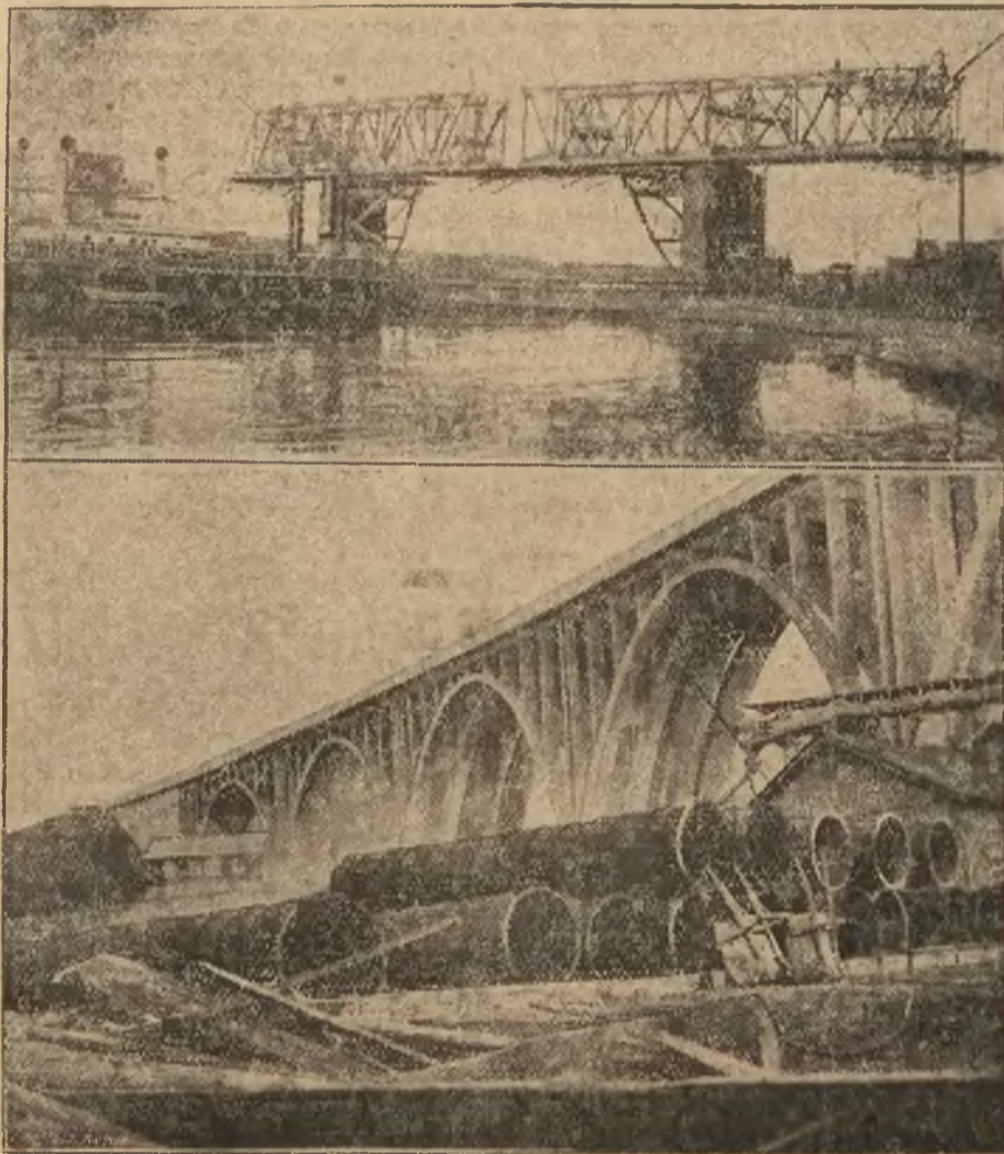
który dzieli półwysep Jutlandzki od wyspy Funen, kończy się budowę wielkiego mostu. O po- teżnych rozmiarach tej budowy świadczą najlepiej zdjęcia.
