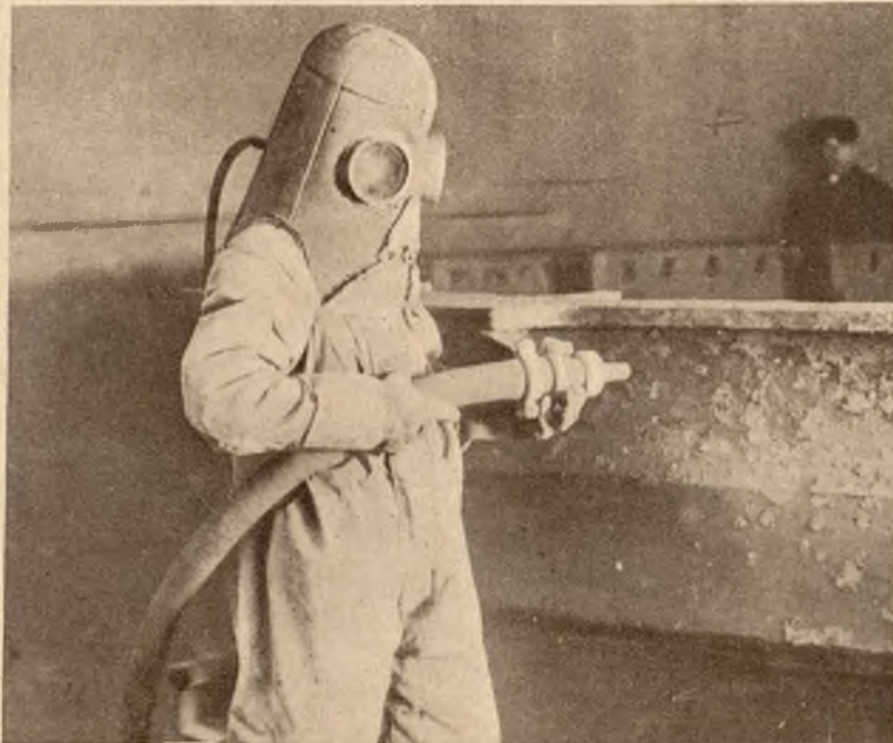
Robotnik w hucie żelaznej rozcinający zapomocą gazu piorunującego bryłę stali.
