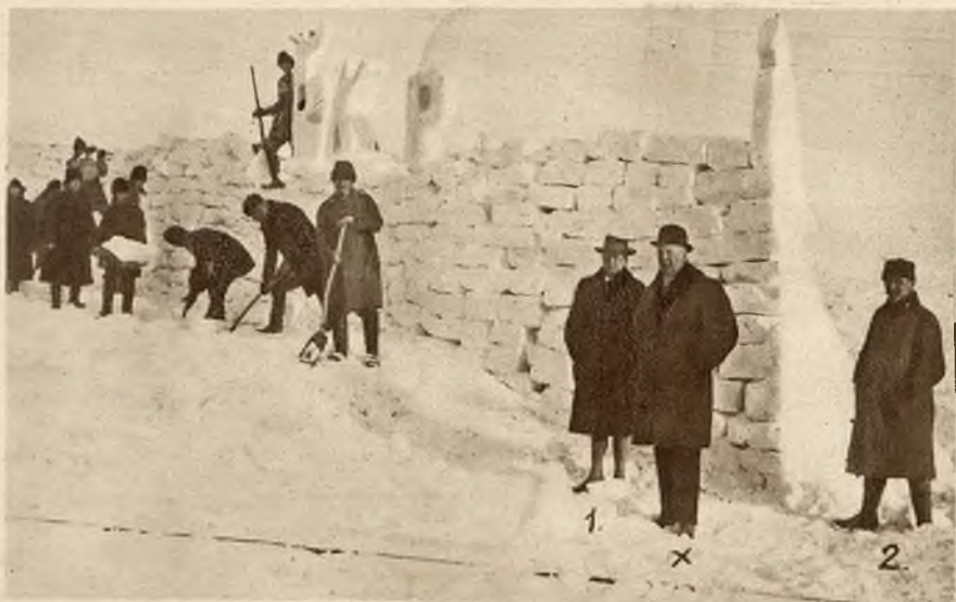
Na poszczególnych liniach kolejowych wybudowano mury z cegiełek śniegowych dla ochrony pociągów przed zawiejami śnieżnymi.
