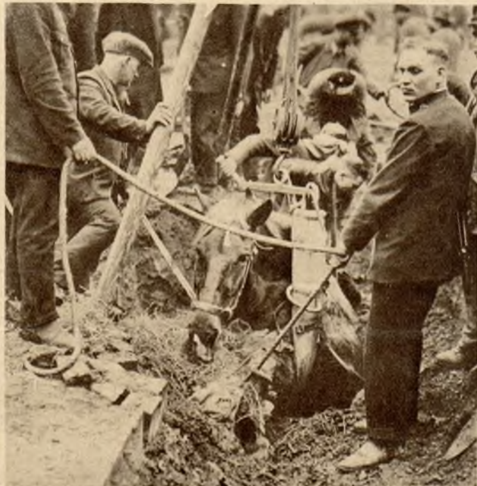
Na ulicy miasta Kassel zdarzył się rzadki wypadek: koń razem z wozem zapadł się pod ziemię. Wypadek spowodowało pęknięcie rury wodociągowej.
