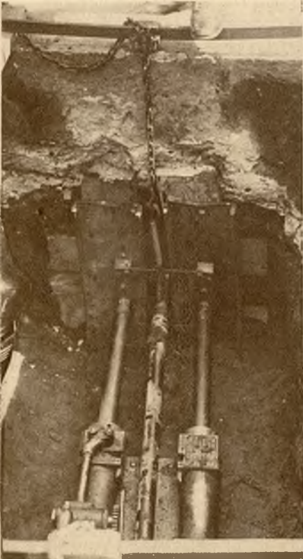
Zdjęcia z pracy nowej maszyny do kładzenia kabla ulicznego.
