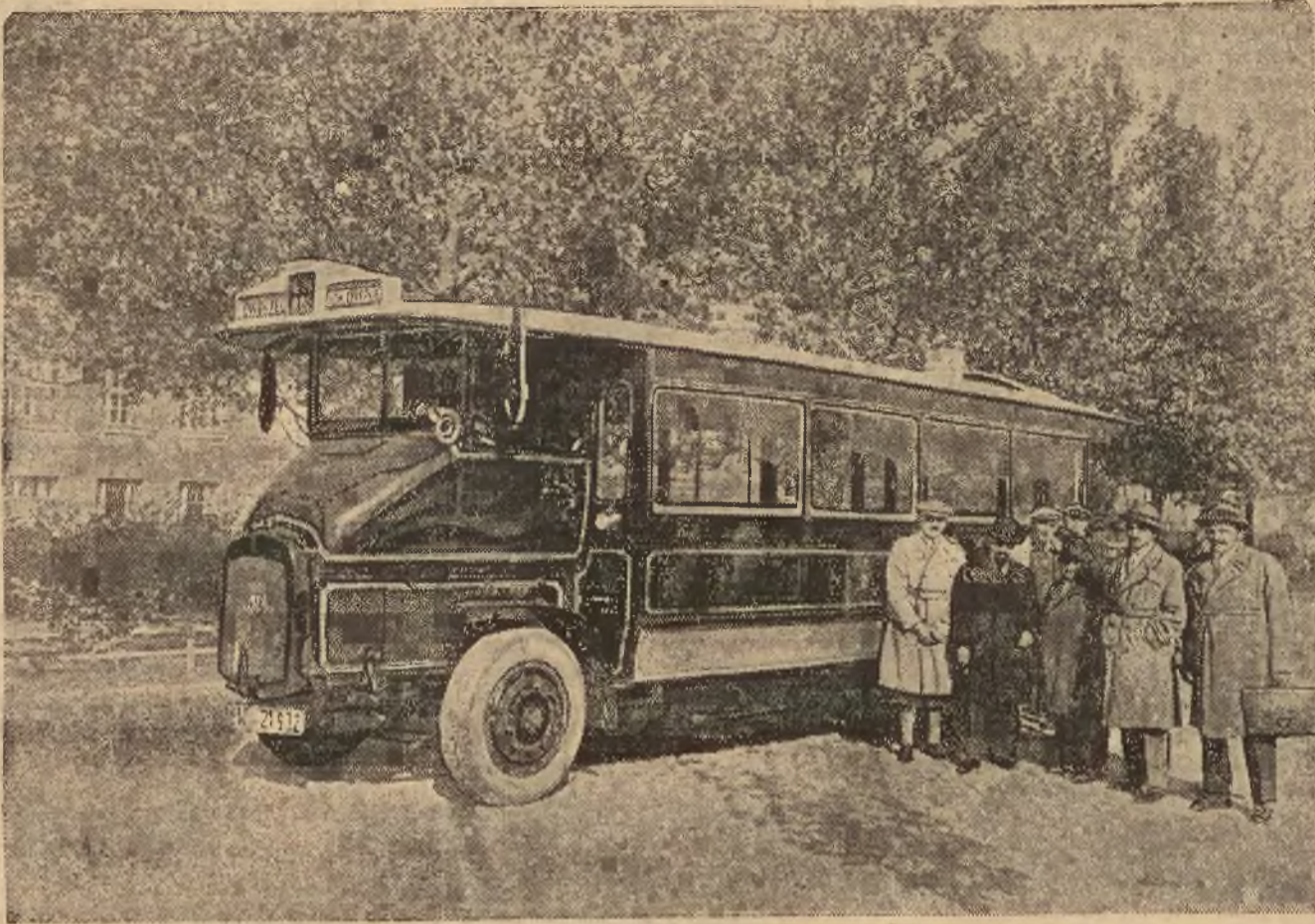
Ilustracja nasza przedstawia autobus wykonany dla gminy miasta Warszawa, w warsztatach fabryki AUTORUCH w Poznaniu, zaopatrzony w opony samochodowe marki „STOMIL” których produkcję rozpoczęła pierwsza w Polsce Centralna Fabryka Wyrobów Gumowych. 8960
