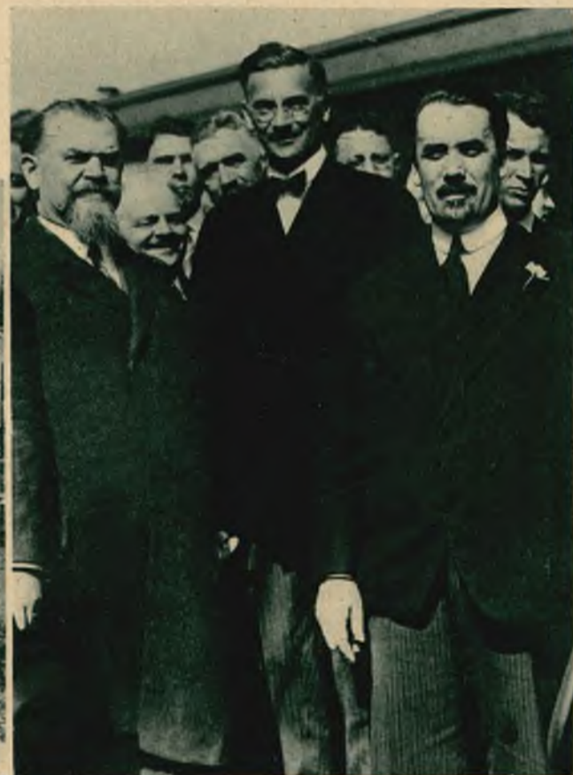
Dnia 5 maja nastąpiło uroczyste uruchomienie ruchu tranzytowego przez Czechosłowację i Polskę do Rumunii. Na górnym zdjęciu ministrowie komunikacji (od lewej) Rumunji Halipa, Polski Kühn i Czechosłowacji Mlcoch, którzy spotkali się na odbudowanym przez Polskę wiadukcie kolej. na Prucie pod Jaremczem (na lewo).
