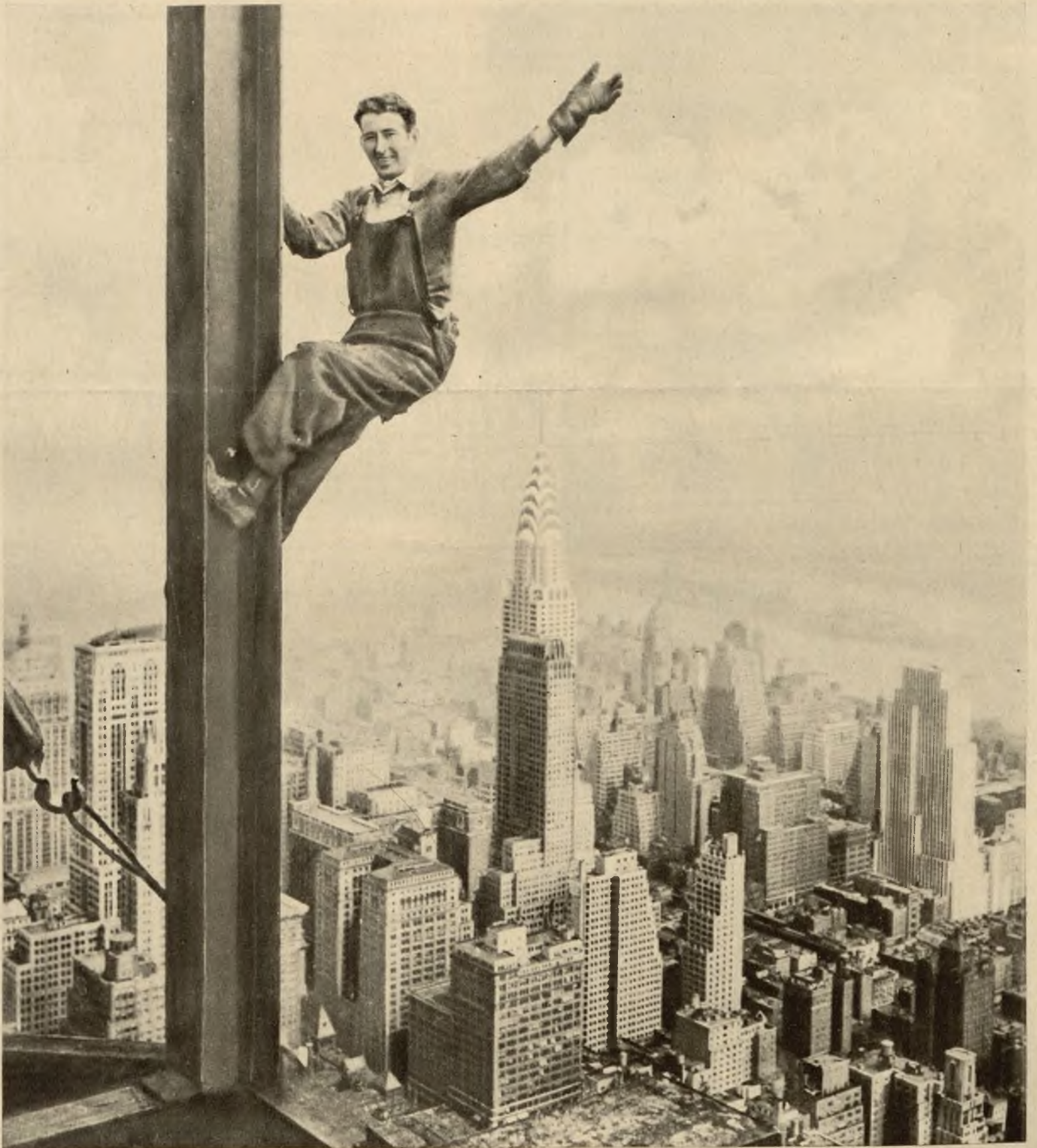
Dotąd najwyższym drapaczem chmur w N. Jorku był „Chrysler”, budynek widoczny w środku fotografii. Obecnie na ukończeniu jest około 400 m wysoki „Empire State Building” najwyższy budynek świata o którego ogromie świadczy powyższa fotografia. Robotnik spinający się po wiązaniach żelaznych jest na wysokości szczytu „Chryslera”.
