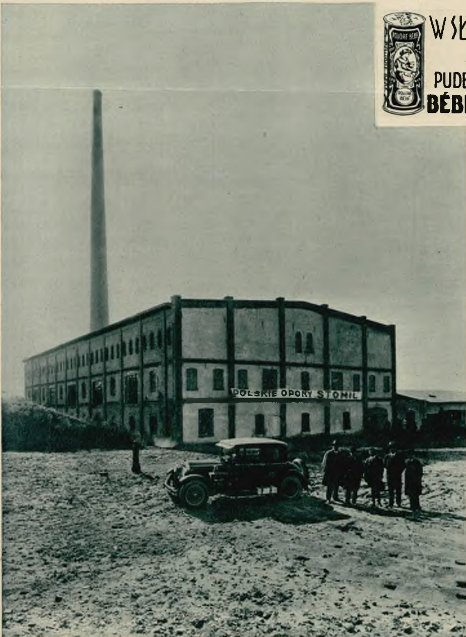
Zabudowania fabryczne pierwszej w Polsce centralnej fabryki wyrobów gumowych w Poznaniu.
